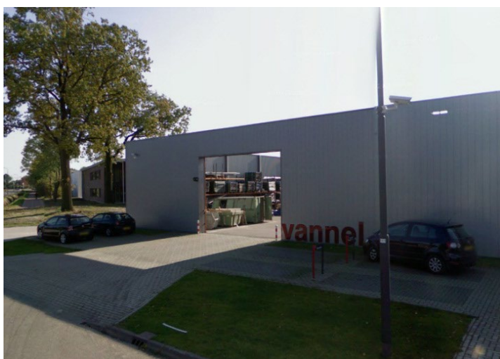
Figuur 8 Wandvorming en opslag uit het zicht.
