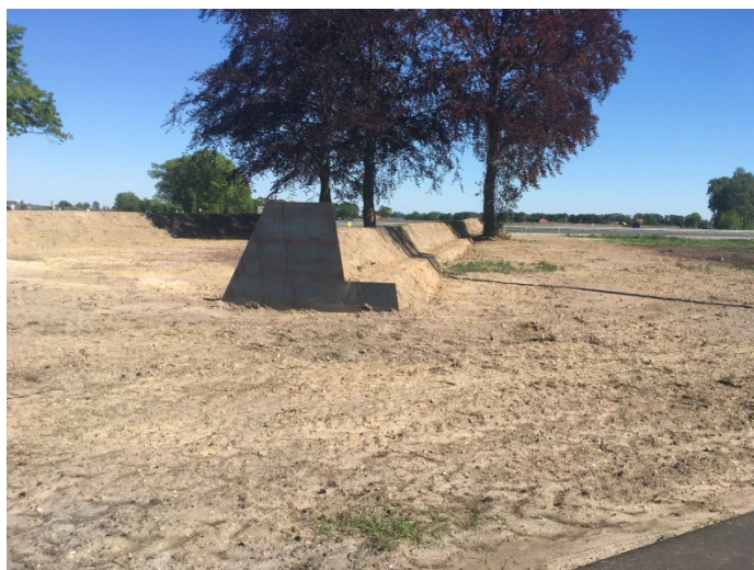
Figuur 25 doorsnijding/beëindiging grondwal door middel van cortenstaal
