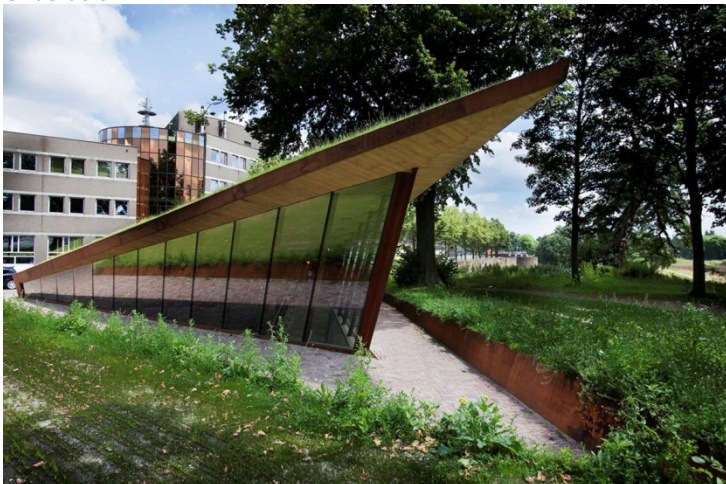
Figuur 14 Referentiebeeld gebouw doorsnijding grondwal
