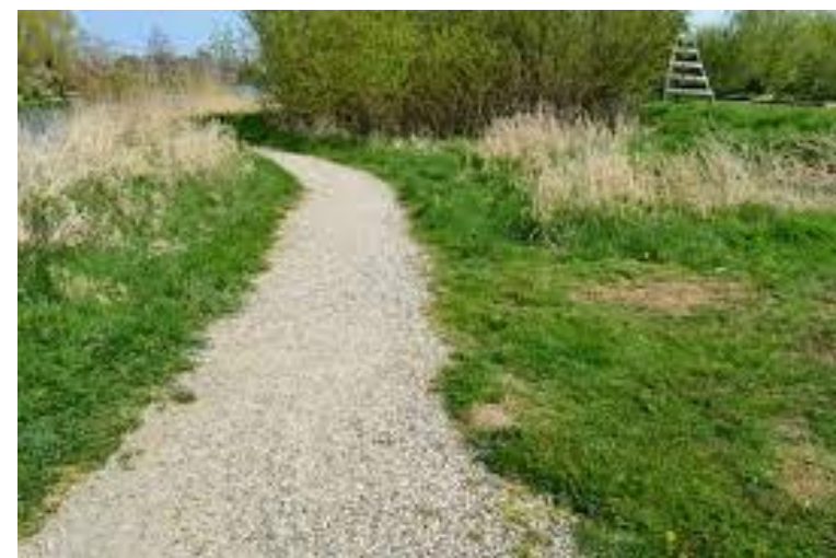
Gebruik van duurzame verharding zoals waterdoorlatende Achterhoeks Padvast en GrASFalt
