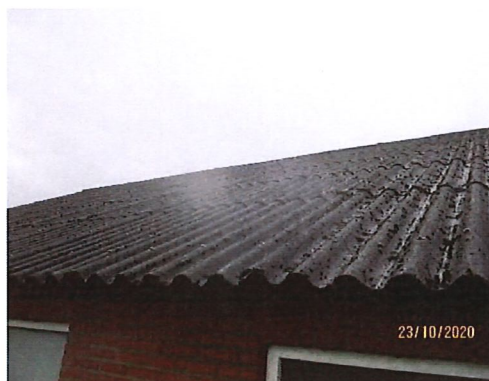
Foto 23: Golfplaten (Abm/009): geen asbest
