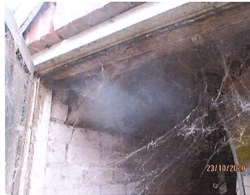
Foto 4: Dupanel onder golfplaten
