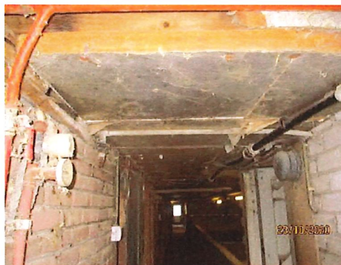
Foto 13: Dupanel onder golfplaten
