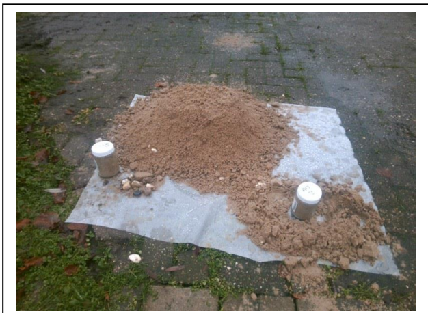
Foto 13. Opgegraven en gezeefd materiaal inspectiegat A13
