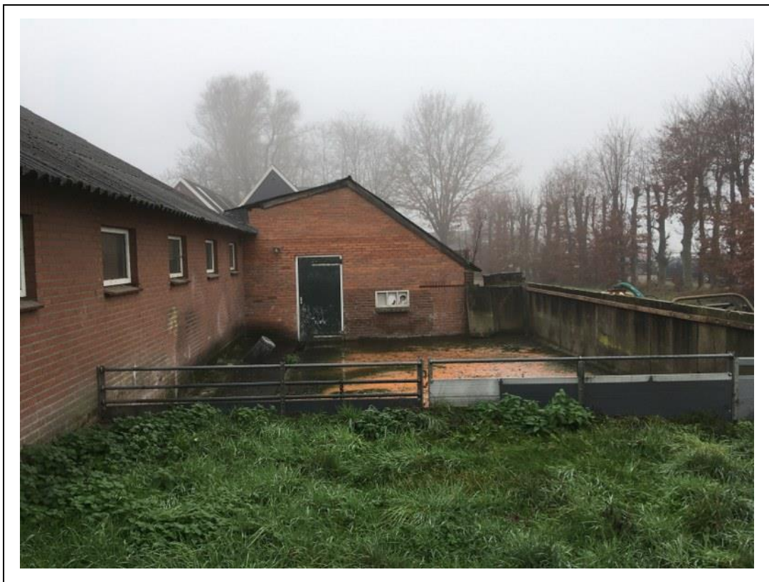
Foto 8. Verdiept uitloophok (beton) voor de varkens.
