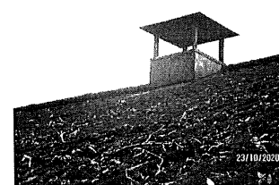
Foto 17: Platen tegen ontluingskokers (006)
