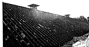
Foto 11: Platen tegen ontluingskokers (Abm/004)
