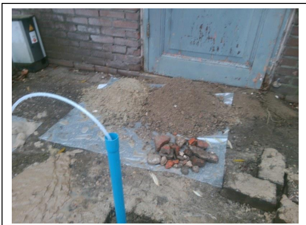
Foto 1. Opgegraven en gezeefd materiaal inspectiegat A01
