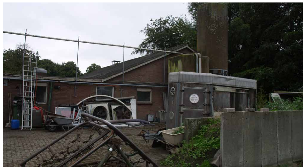
Afbeelding: Te slopen bebouwing
