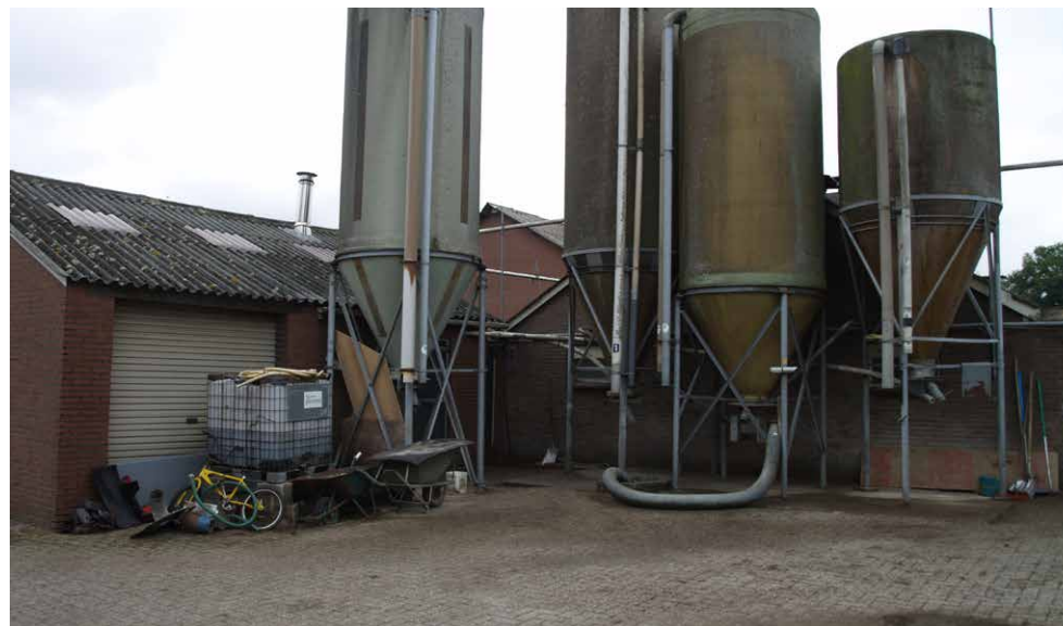
Afbeelding: Te slopen bebouwing
