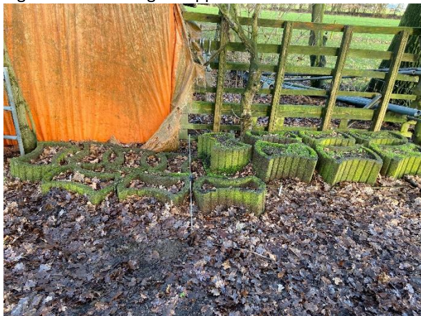
Figuur 17: Aanwezige demping
