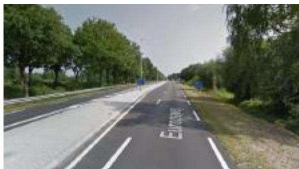
N18 ter hoogte van hectometerpaal 224.9 vanuit het westen (augustus 2017)
