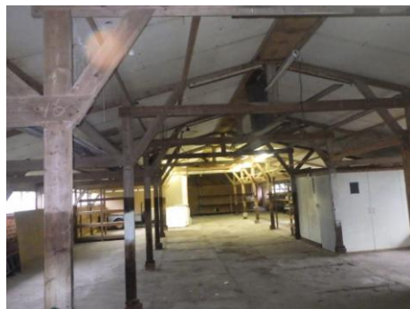
binnenzijde gesloten dakconstructie schuur 2
