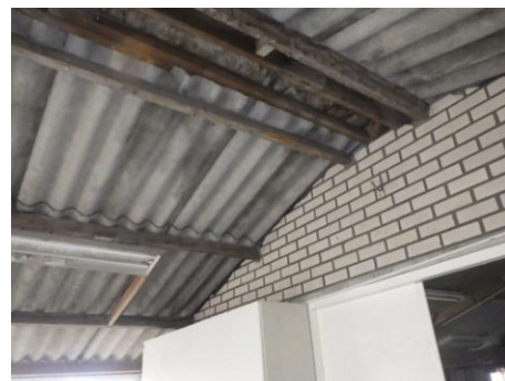
binnenzijde dakconstructie schuur 1
