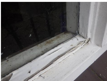
niet asbestverdacht stopverf
