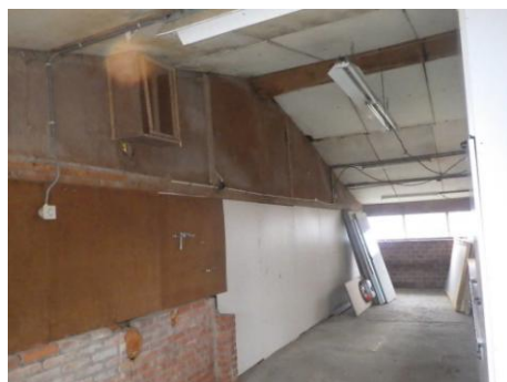
binnenzijde gesloten dakconstructie schuur 2
