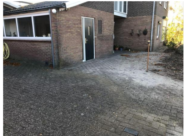
Figuur 8: Dak(goot) bebouwing
