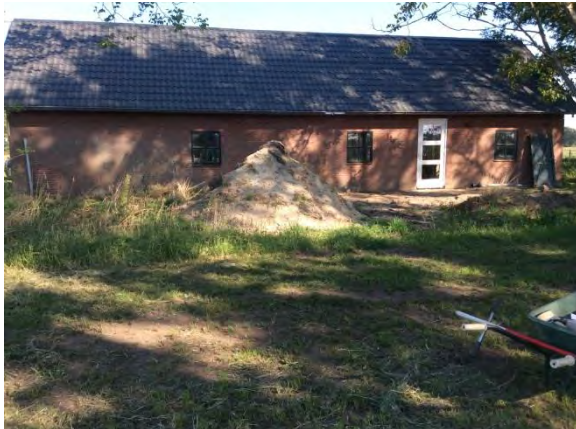
Figuur 8: Overzichtsfoto bebouwing
