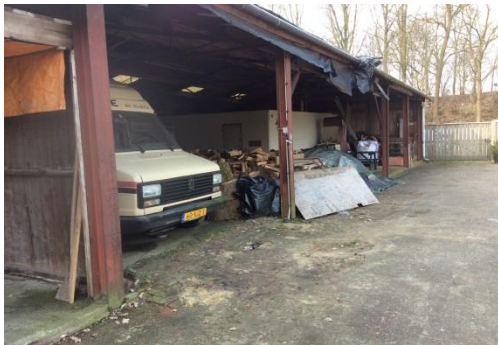
Figuur 8: Overzichtsfoto bebouwing
