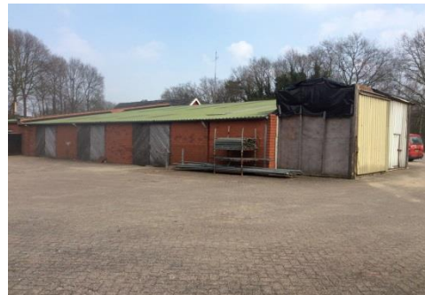
Figuur 9: Overzichtsfoto bebouwing
