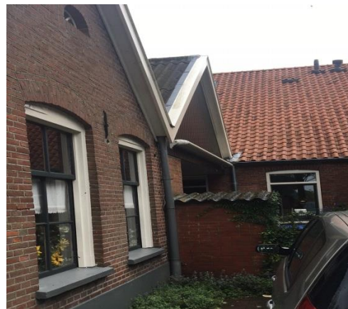
Figuur 9: Dak(goot) bebouwing
