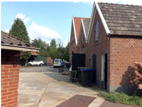
Figuur 8: Overzichtsfoto bebouwing
