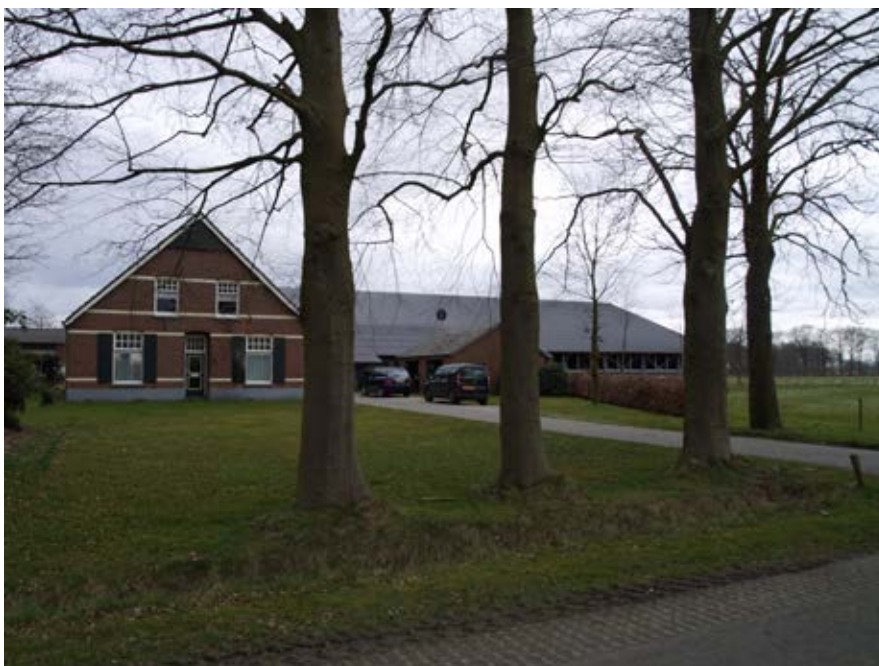
Foto hierboven: Het bestaande erf met woonhuis en stallen vanaf de Klaverdijk.
