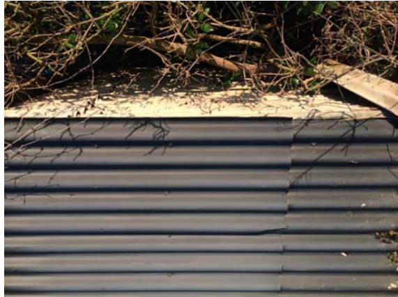
Afbeelding 13: asbestverdacht materiaal-1
