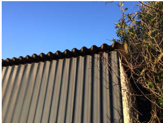
Afbeelding 14: asbestverdacht materiaal-2
