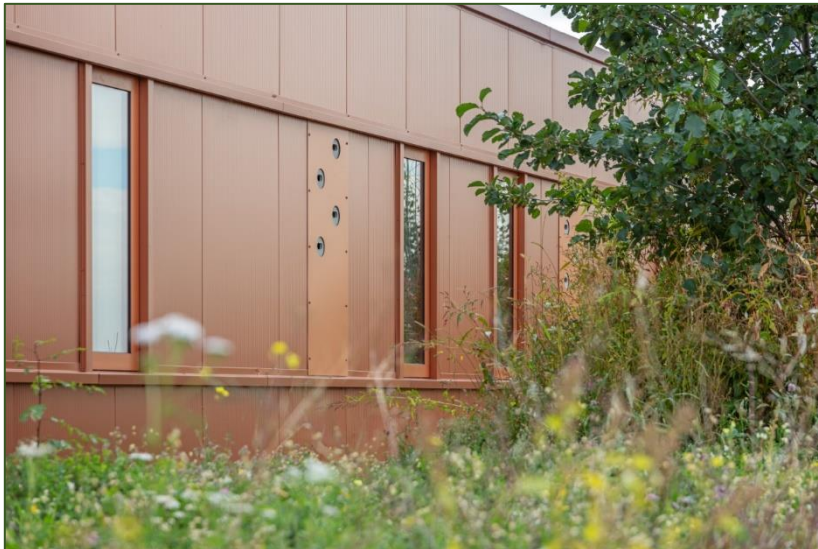
Figuur 4: Principevoorbeeld van houtbetonnen inmetselfkasten achter gevelbekleding. (op de foto gierzwaluwkasten). De vleermuiskasten zullen hoger in de gevel worden aangebracht en voor een groter deel zichtbaar zijn.
