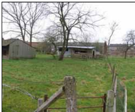
te slopen bebouwing in deelgebied 1 (foto's SAB)
