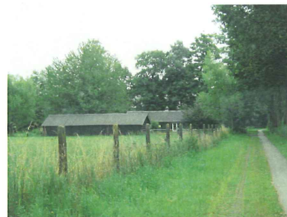
Foto 1: Zij aanzicht schuur I met achterliggende woning
