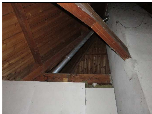
Foto 5. Zolder van voormalig gemeentekantoor
