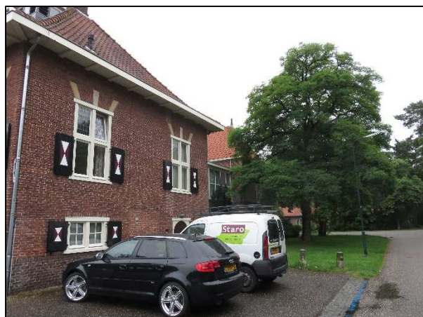
Foto 3. Zijkant voormalig gemeentekantoor
