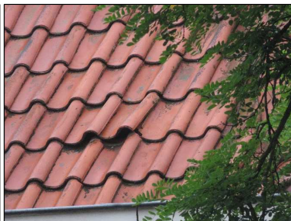
Foto 6. Dak van voormalig gemeentekantoor
