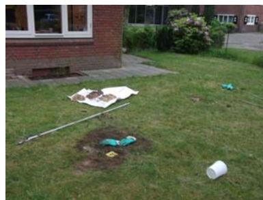
Foto 5: Verwachte locatie tank Raadhuisplein 2
