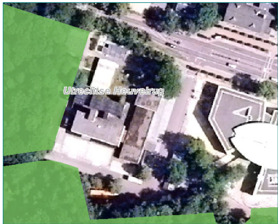
Luchtfoto 1: plangebied met in groen de EHS
