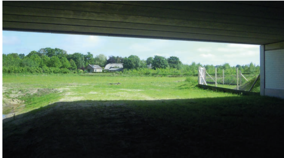
Faunapassage Hoge Woerd, zicht naar het noorden
