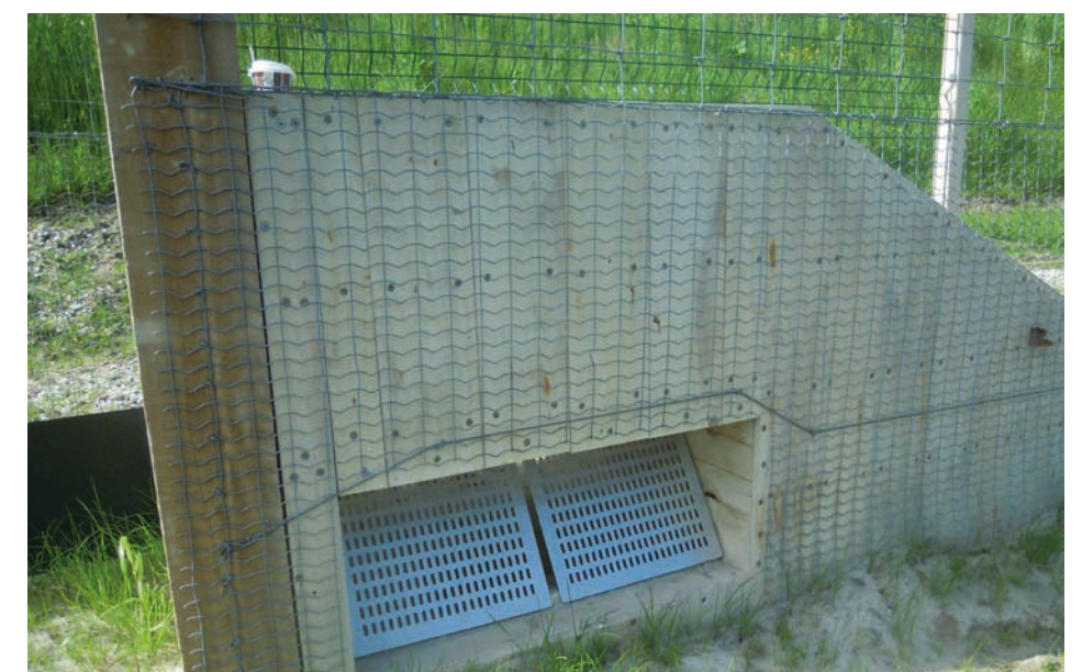
Voorziening voor ingesloten reën en dassen
