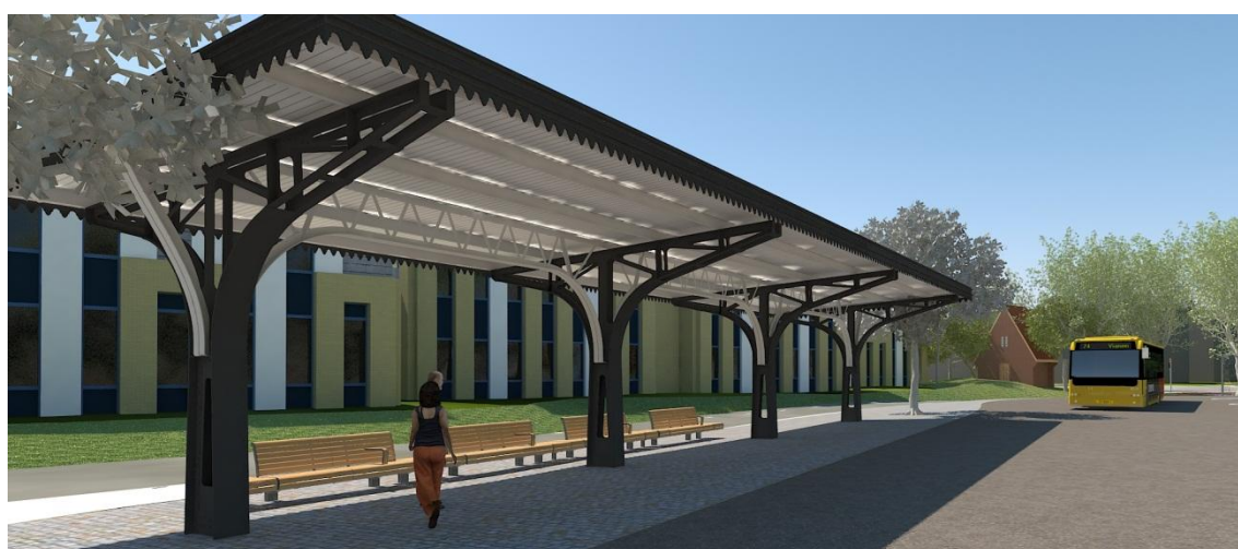
Afbeelding 25 Wachtruimte busreizigers met o.a. geprofileerde dakrand, dakbeschot schroten met kraal en restauratie samengestelde open spanten
