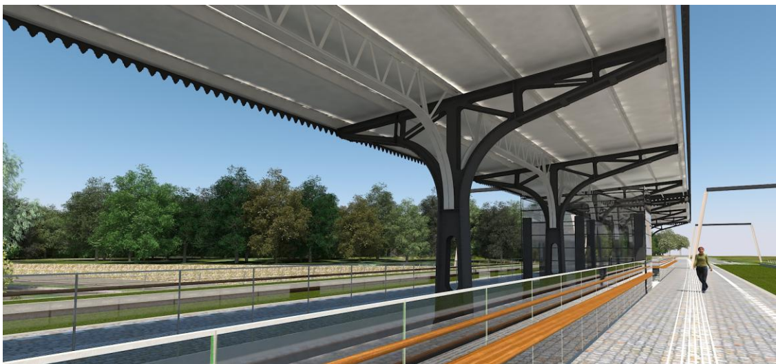
Afbeelding 20 Impressie gezien vanaf perron. De kap is te smal voor het nieuwe perron en biedt onvoldoende bescherming voor de wachtende reizigers
