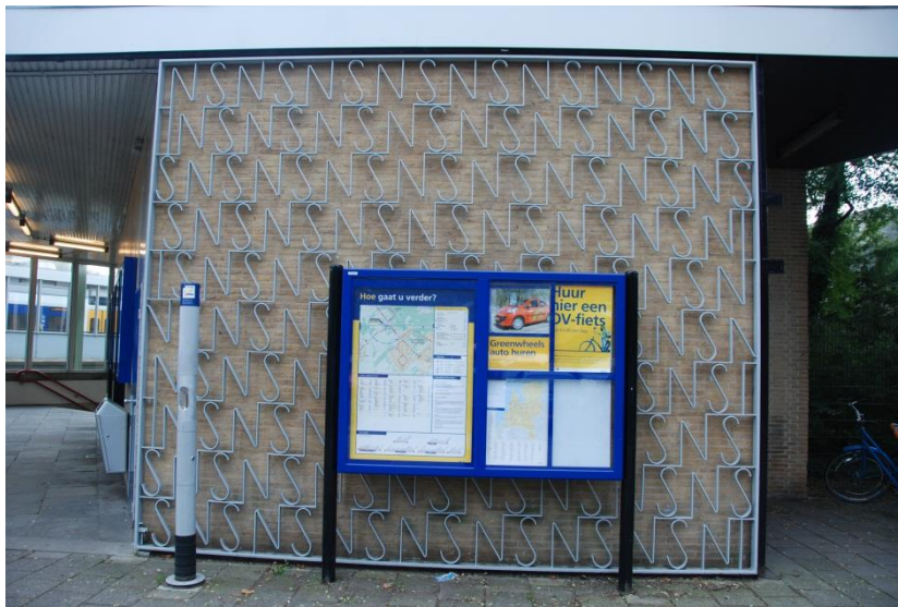
Afbeelding 35 Sierhekwerk, 4.4 meter breed en 3.65 m hoog, voor de afsluiting van de ingang van het station aan de Zeister zijde
