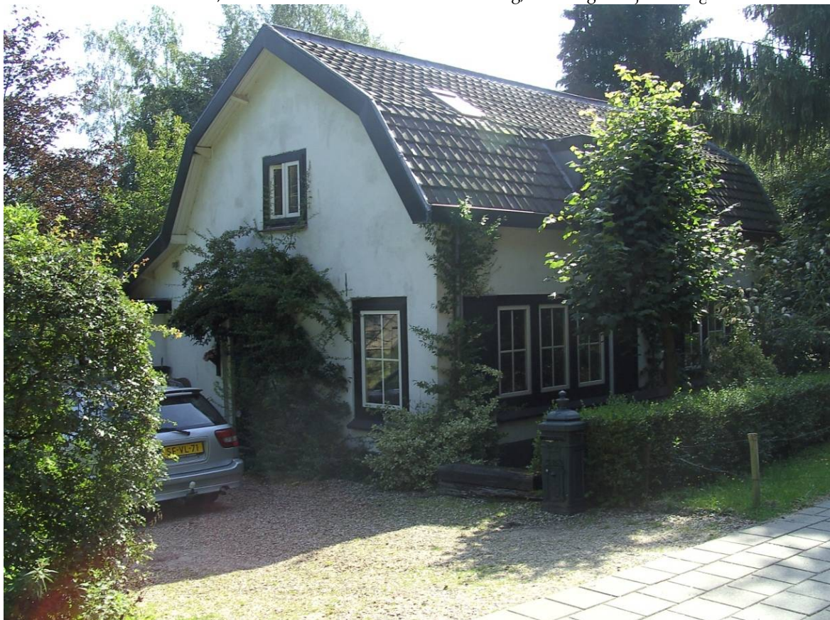
Locatie 1.5, Woonhuis aan de Arnhemsebovenweg, Driebergen Rijssenburg
