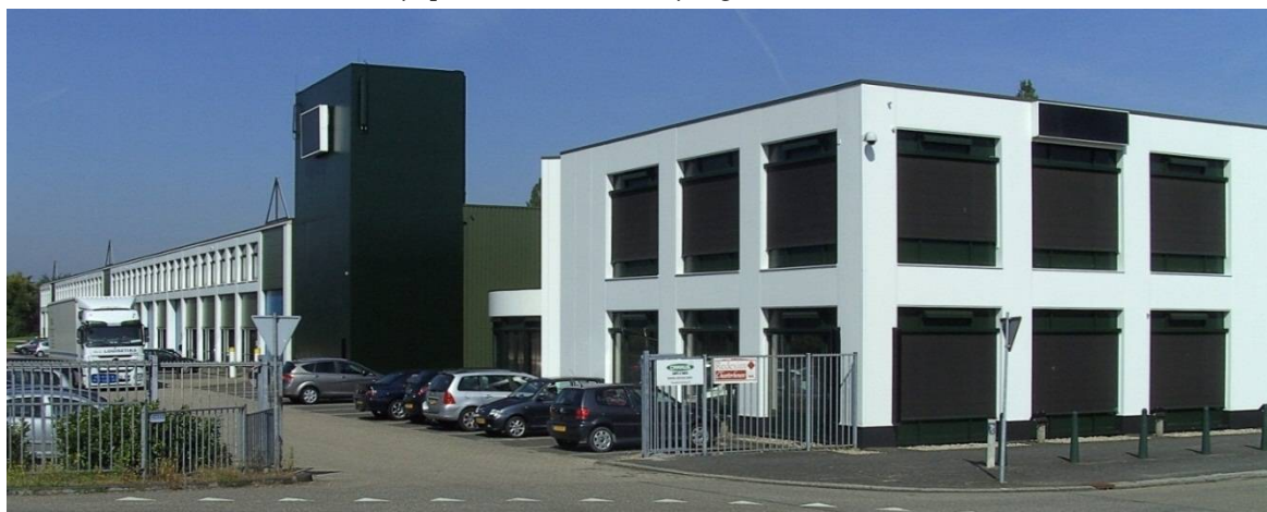
Locatie 3.8, Bedrijfspand aan de Kwekerijweg, Zeist
