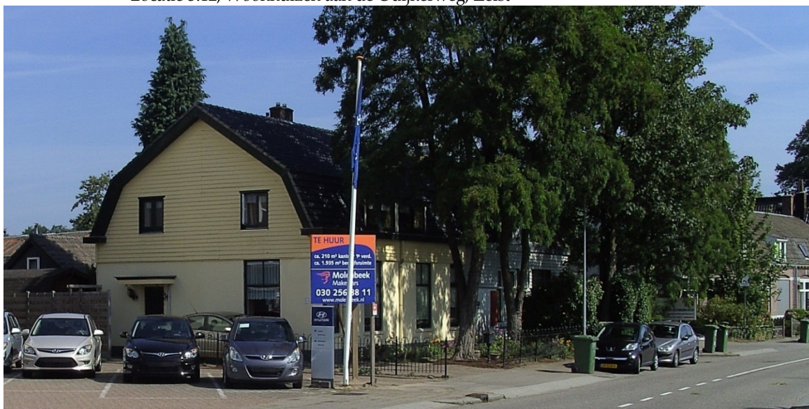
Locatie 3.12, Woonhuizen aan de Odijkerweg, Zeist
