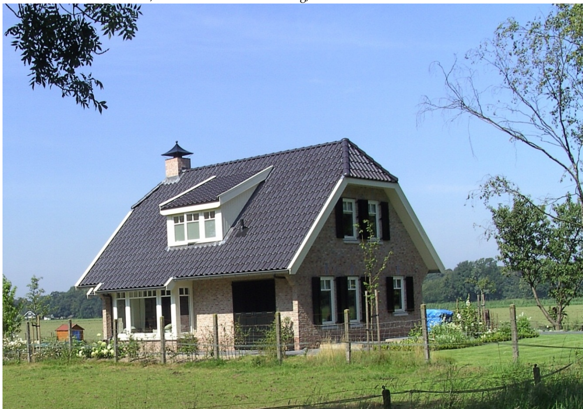
Locatie 5.5, Woonhuis aan de Tiendweg, Zeist
