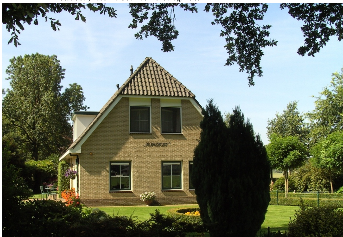
Locatie 5.4, Woonhuis aan de Tiendweg, Zeist
