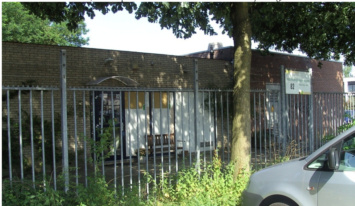
Locatie 3.5, Kantoorpand en onderstation ProRail aan de Odijkerweg, Zeist
