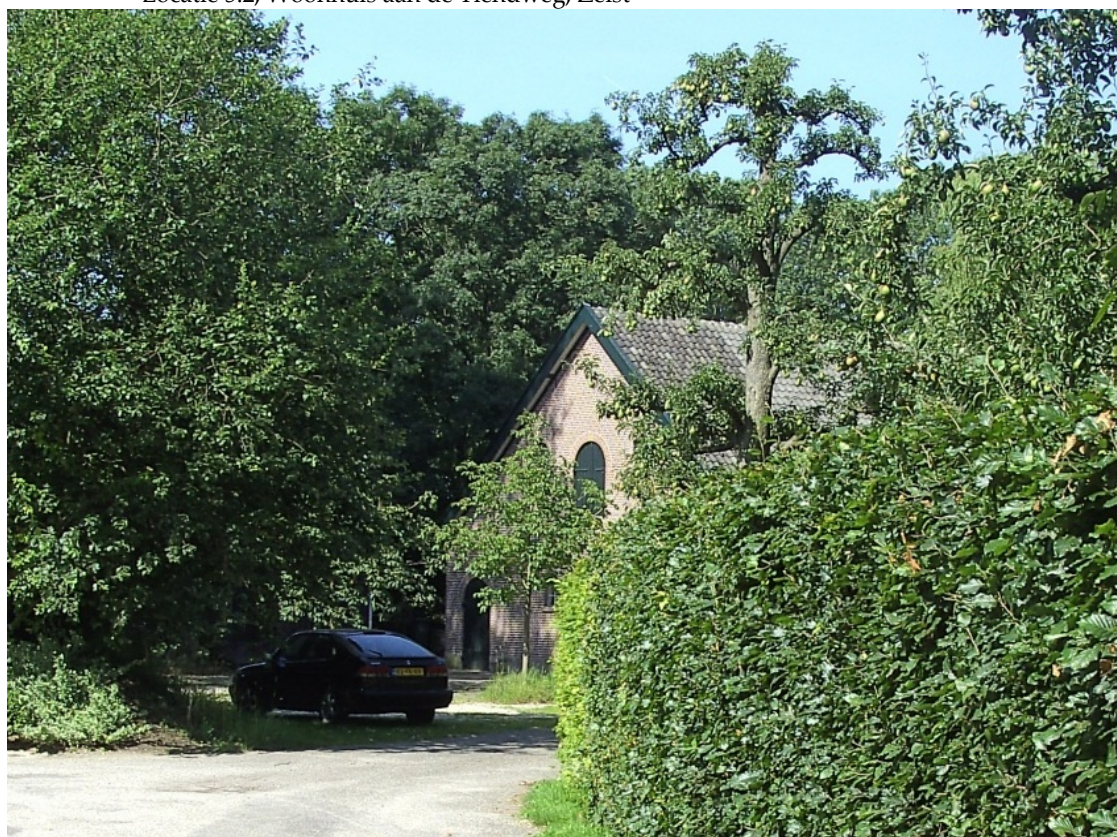
Locatie 5.2, Woonhuis aan de Tiendweg, Zeist
