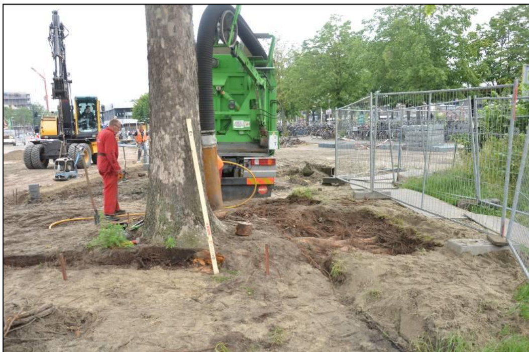
Werken met een grondzuiginstallatie bij de inpassing van een plataan in Bergen op Zoom.
