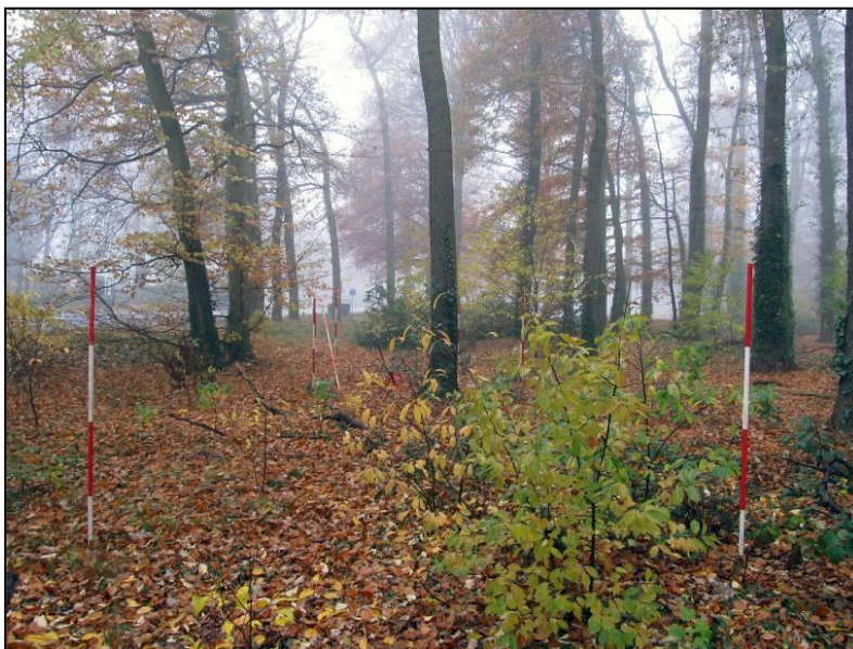
Het toekomstige wegtracé is in het veld uitgezet, om de best mogelijke route door de bosstrook te vinden.
