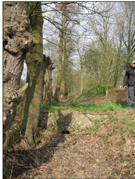
Het achterste deel van de zaksloot op De Reehorst.
