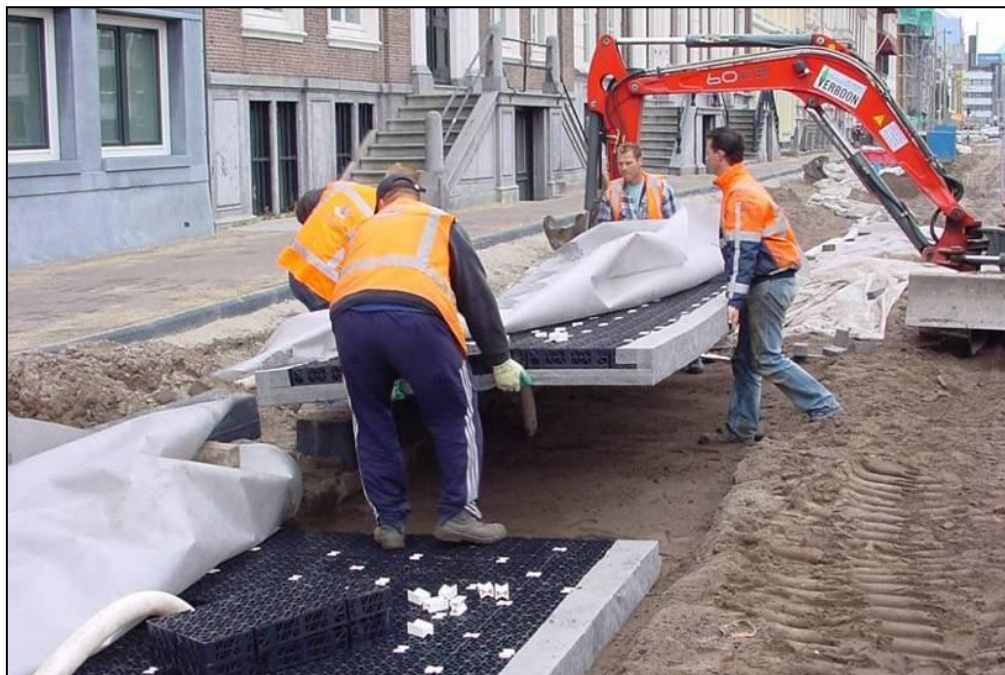
Het plaatsen van de kunststofplaten voor de aanleg van een parkeerplaats op bomenzand in Den Haag.
