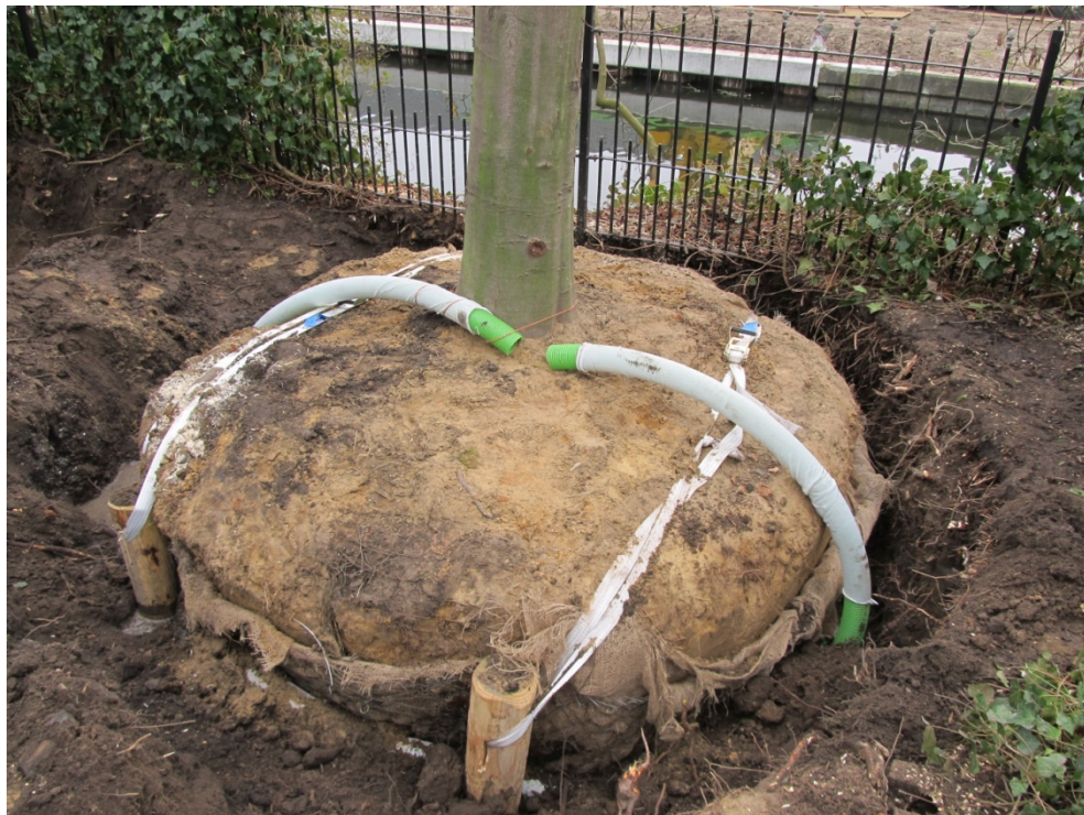
Ondergrondse verankering met beluchtingsdrain
