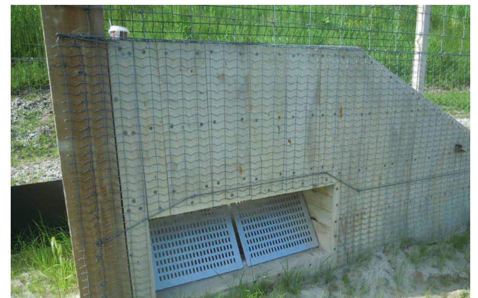
Voorziening voor ingesloten reën en dassen
