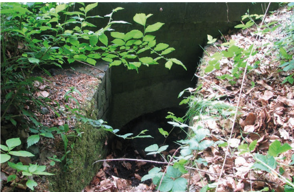
Huidige duiker onder spoor. Door verbreding spoor kan deze niet blijven.
