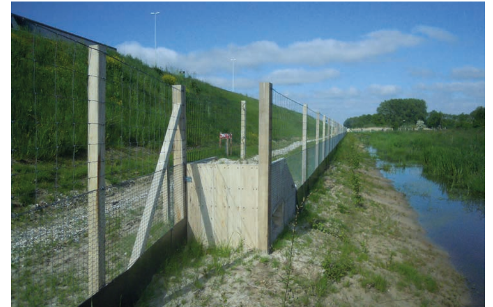
Voorziening voor ingesloten reën en dassen
