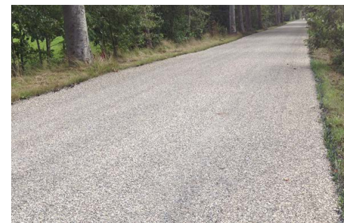
grind-toplaag op asfaltweg
