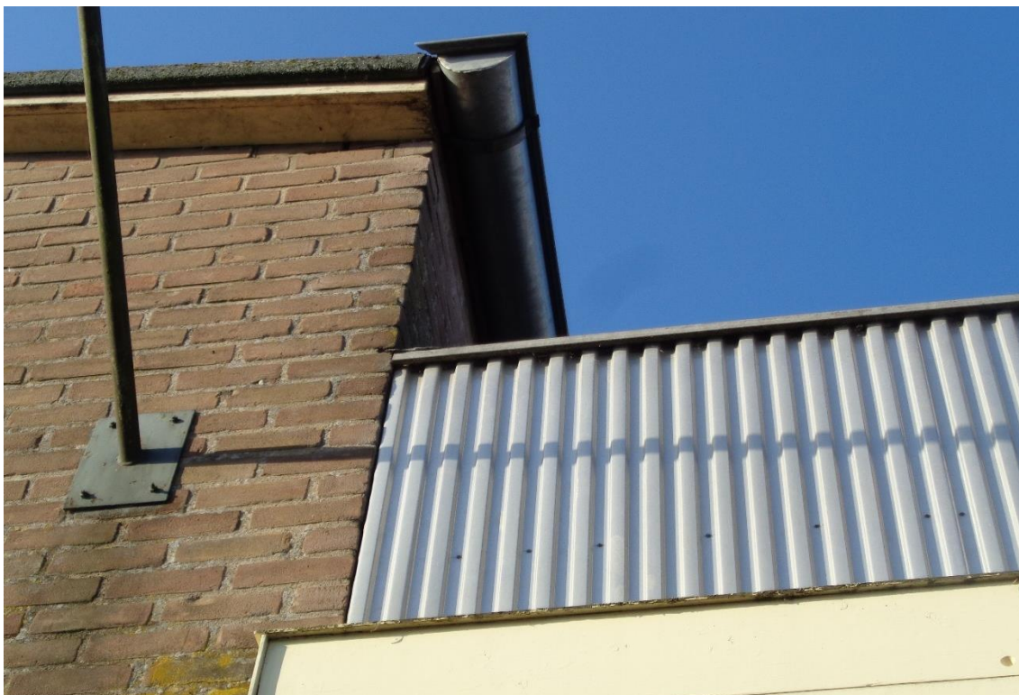
Figuur 6. De dakrand van de stal. Bij de bevestiging van de dakgoot zitten kleine ruimtes in de dakrand. Het plaatmateriaal van de hobbyruimte is strak afgewerkt. Er zijn geen ruimtes aangetroffen.
