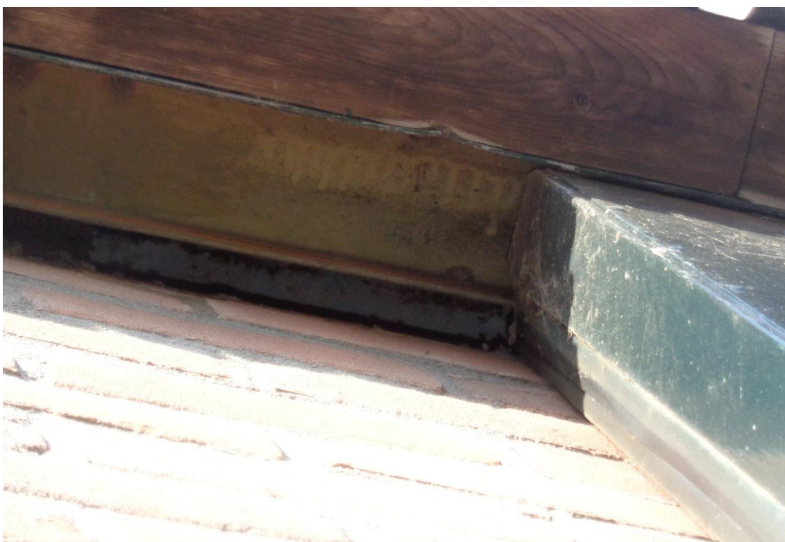
Figuur 7. De afwerking van de schuifdeuren. Er is hier een ruimte van 5 à 10 centimeter diep, hier schuift de deur door. Echter, deze deuren gaan zelden open.
