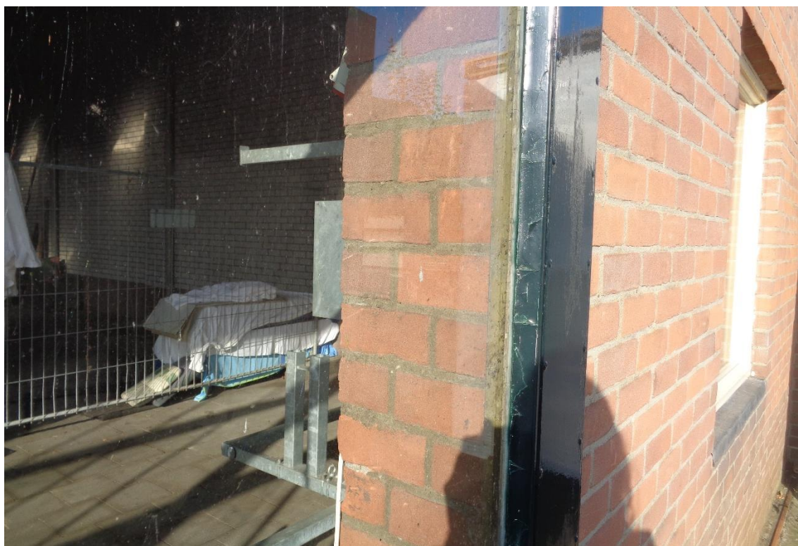
Figuur 5. De muur van de hobbyruimte.
