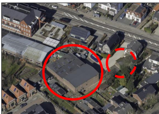
Figuur 1.1 Huidige situatie | zicht vanuit zuid
