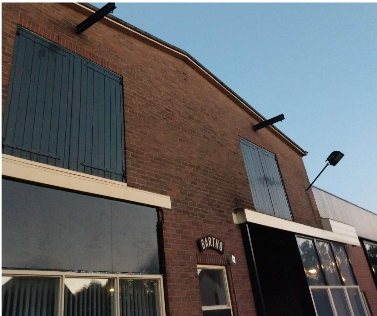
Figuur 2. De locatie aan de voorzijde van de stal waar een zomerverblijfplaats van gewone dwergvleermuis is waargenomen.
