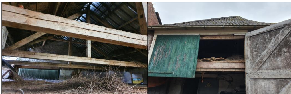
Figuur 5 Schuur E met zichtbaar een afgesloten zolder met enkel een opening in het dak aan de westelijke zijde van het gebouw.
