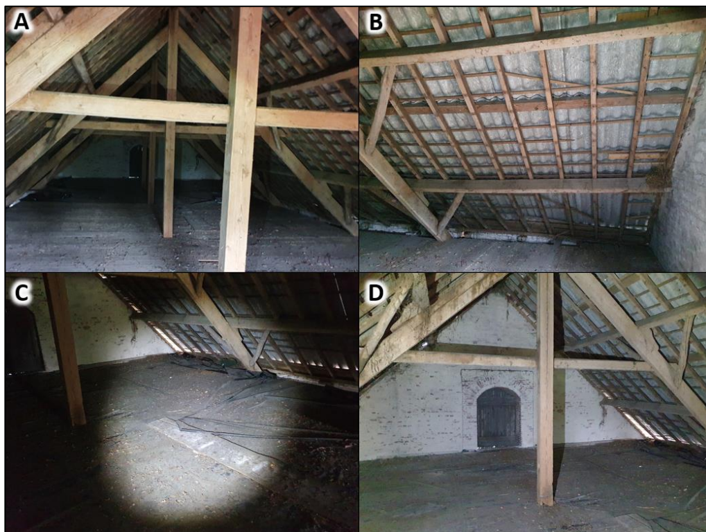
Figuur 4 Schuur C verkeerd in zichtbaar betere staat dan schuur B. Het ontbreken van dakbeschot en een spouw zorgt echter dat er geen sprake is van mogelijke vleermuis verblijfplaatsen.
