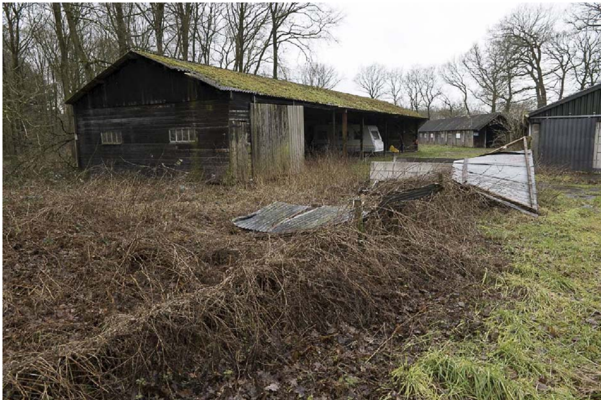
Achterste deel van het erf van Dwarsweg 69 met links de kapschuur (69-3) en op de achtergrond de kippenstal (69-4)
