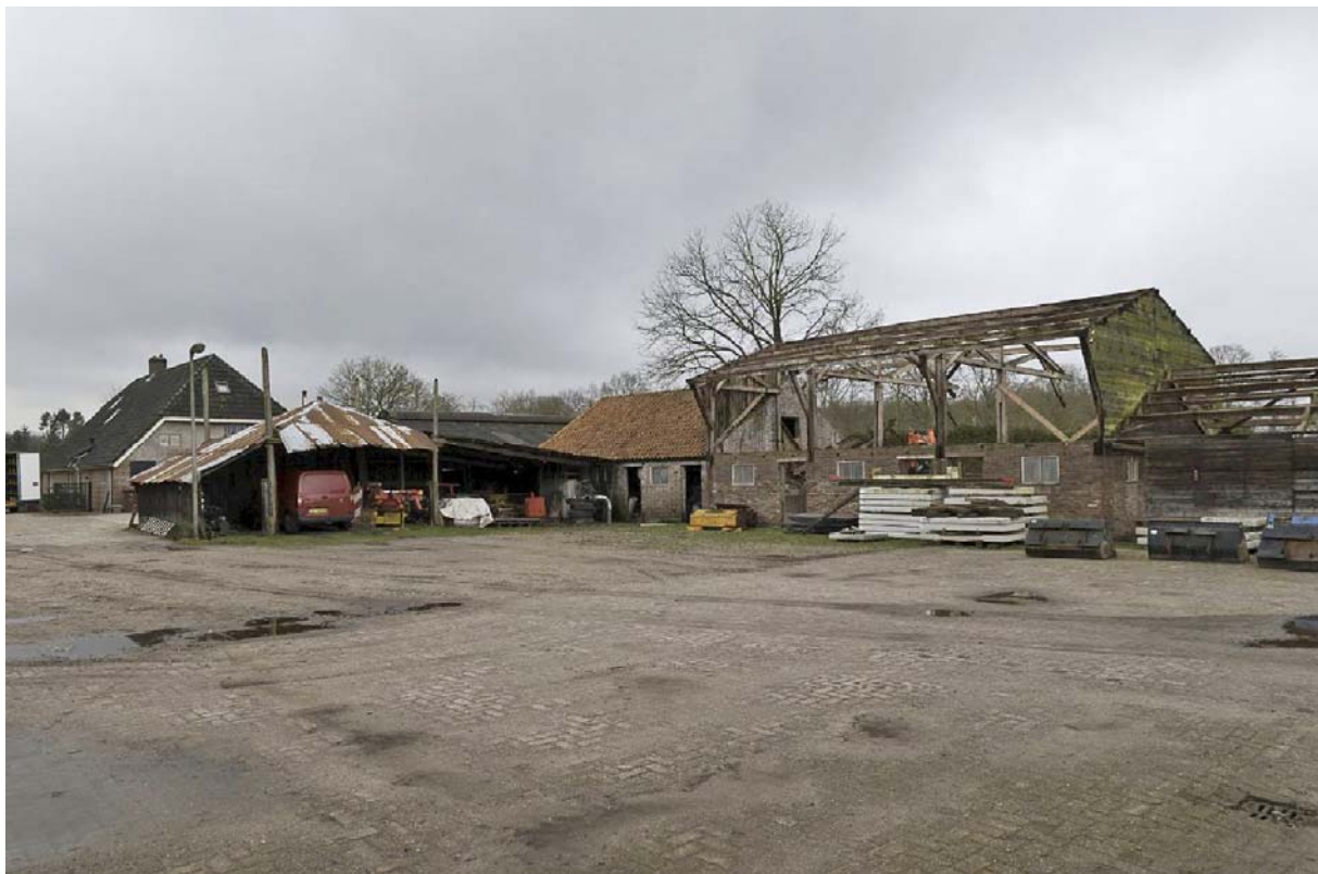
Het schurencomplex (62-3) op het erf van de boerderij Dwarsweg 62
