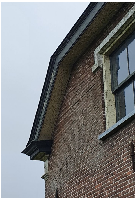
Tussen de houten dakrand en buitenmuren bevinden zich in de boerderij op veel plaatsen kieren. Foto: | Ecoresult B.V.
