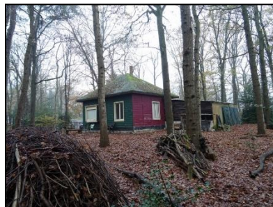
Figuur 4. Woning op onderzoekslocatie, gezien vanuit het zuidwesten.
