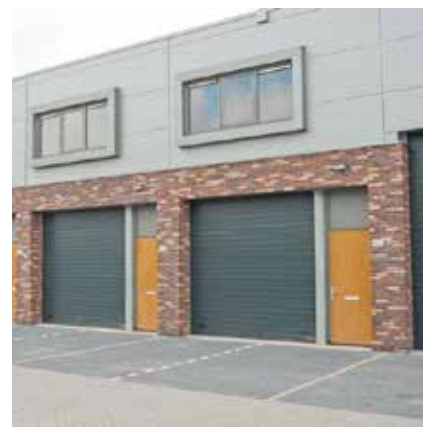
Referentiebeeld parkeren op eigen terrein
