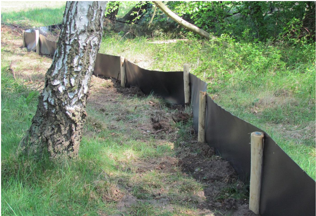
Ingegraven reptielenscherm rondom een wegvanglocatie (HV)
