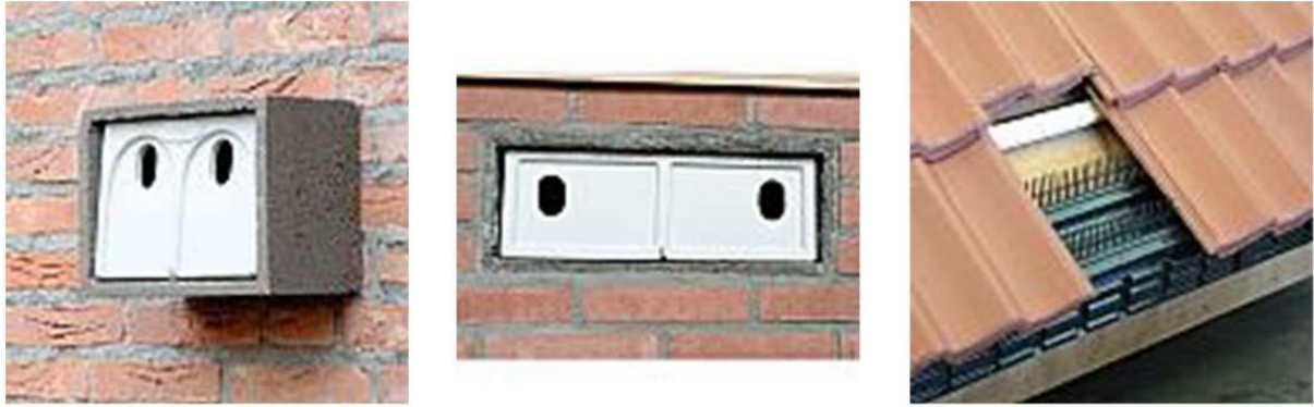
Figuur 13. Alternatieve nestplaatsen voor de huismus Links: nestkast; midden: nestkast (inbouw); rechts: vogelvide Bron: www.vivara.nl
