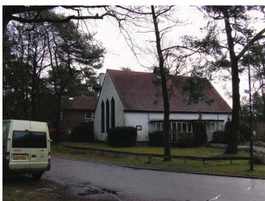
Overzicht linker zijgevel kerk en woning
