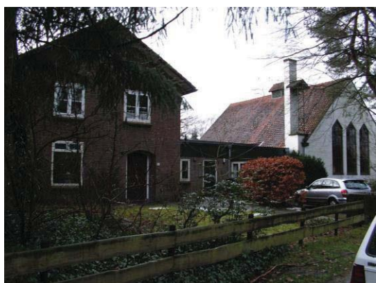
Overzicht achtergevel kerk
