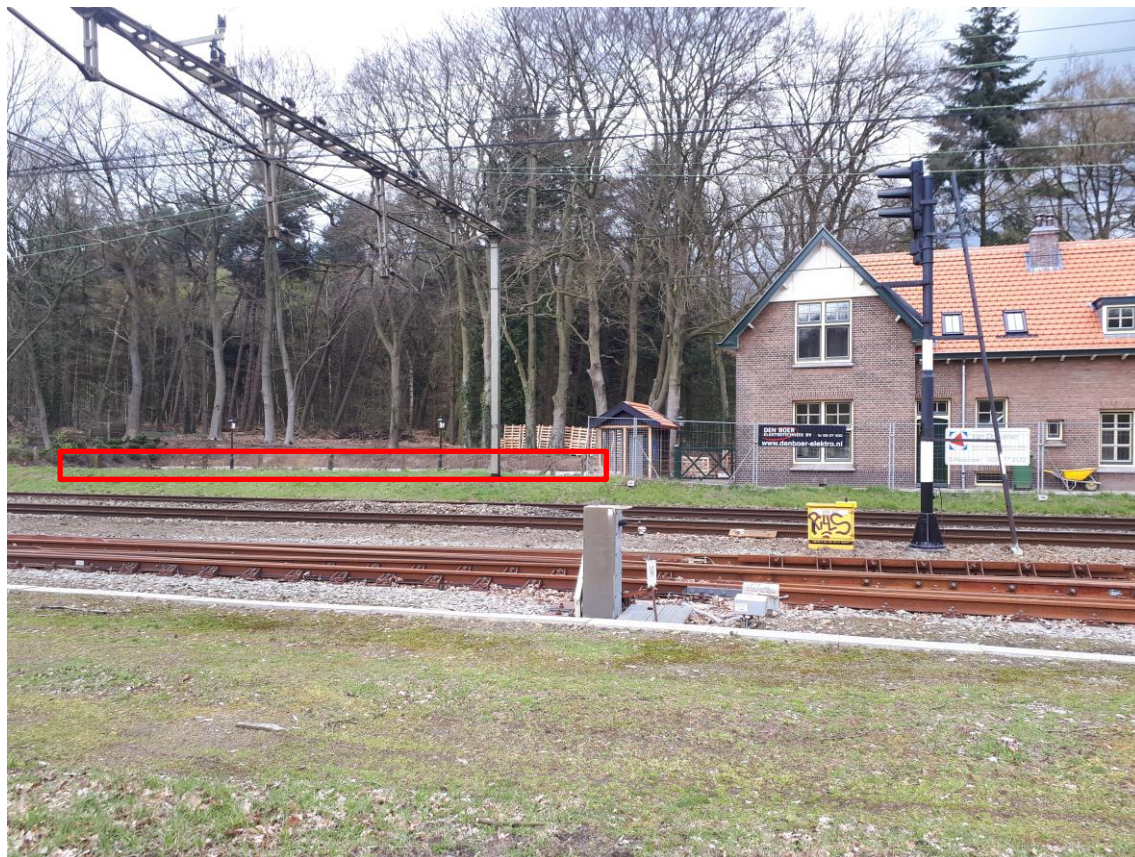
Figuur 4.2 ligging onderzoeksgebied (rode omlijning) gezien vanuit overzijde spoorweg (foto Ecogroen)
