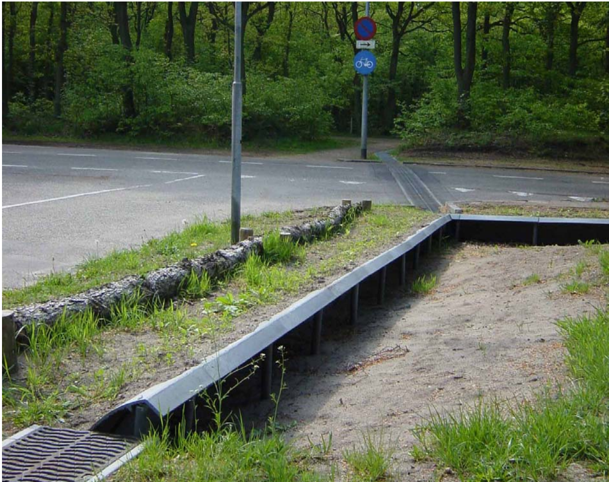
Amfibietunnel met schermen in een verharde weg (HB)
