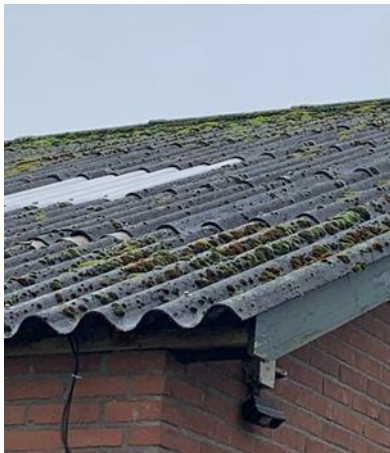
Figuur 27 detailfoto asbestverdacht dak zonder dakgoot
