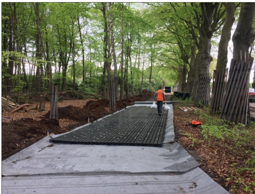
Afbeelding 44: Aanbrengen permavoid boomkratten als fundering voor verharding;
