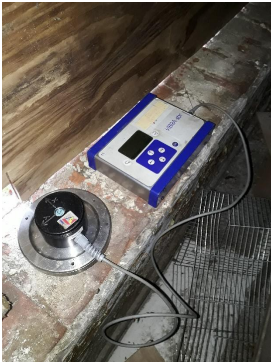
Meetpunt 4, fundatie monument
