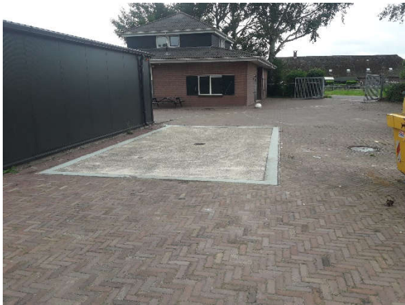
Foto 3: Wasplaats (deellocatie A)
