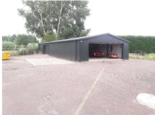
Foto 2: Opslagloods met wasplaats (deellocatie A en B)
