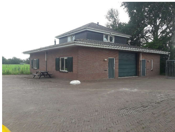
Foto 6: Personeelsruimte met werkplaats met inpandige vloeistofdichte vloer
