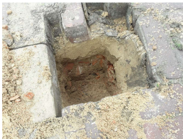
Foto 8: Laag gepakte bakstenen (oude verhardingslaag) onder cunetzand en klinkerverharding rond de opslagloods
