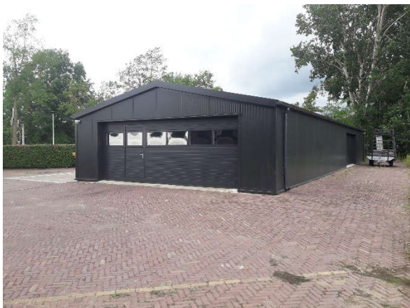
Foto 5: Opslagloods en voormalige zoutopslagplaats (deellocatie B)
