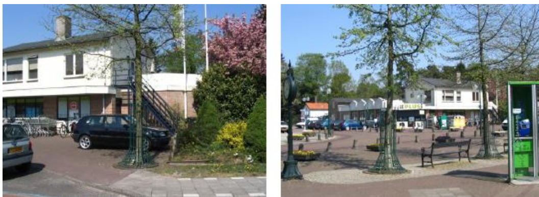
Afbeelding 4 en 5: foto's voormalige situatie supermarkt
