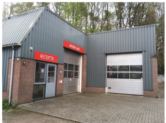
Figuur 6 Voorzijde werkplaats.
