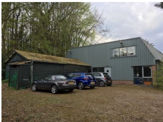
Figuur 4 Achterzijde werkplaats.
