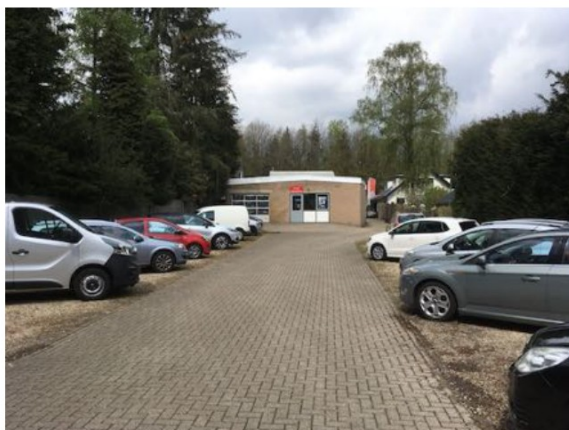
Figuur 5 Achterzijde showroom.
