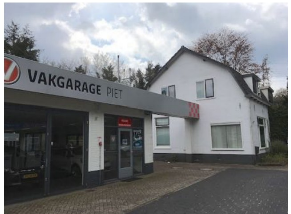
Figuur 8 Showroom en woning.
