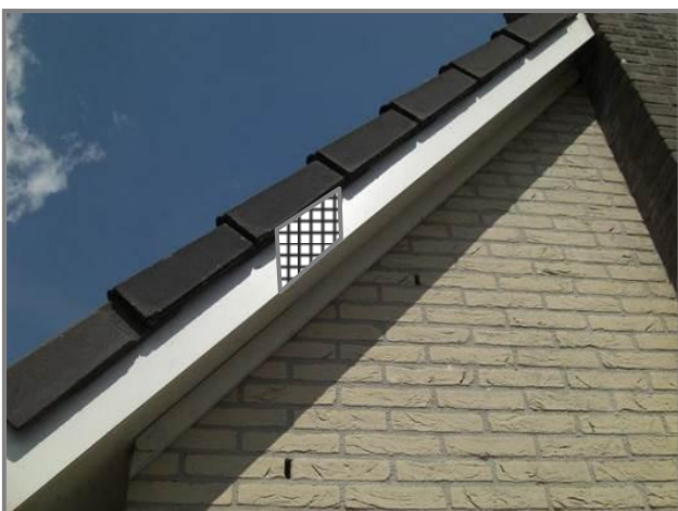
Figuur 12 | Overhangende gevelpannen op glad Tresa met een grip voorziening (fijn gaas of mee geschilderd ruw zand) voor vleermuizen.
