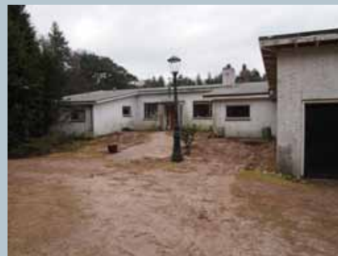
Woning 1 aan de noordzijde (entree)
