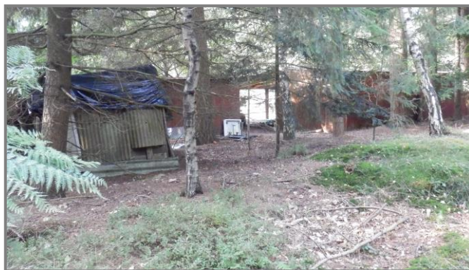
Aanbouwjes met asbest golfplaten
