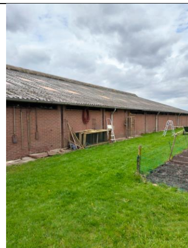
Het dakvlak bestaat uit golplaat.
