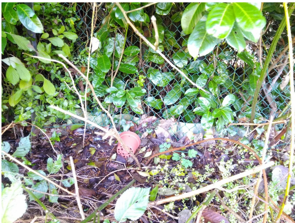
Foto 5: asbestverdachte beschoeiing op aangrenzend perceel (Bakkersweg 30)
