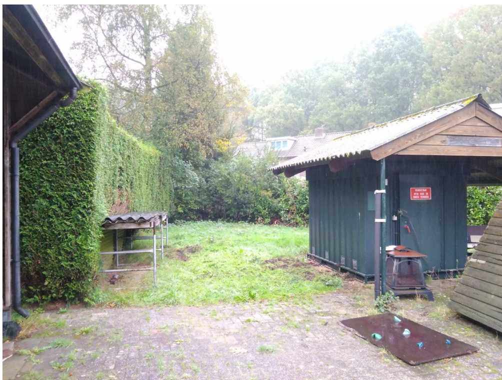
Foto 4: deellocatie gebouw E (rechts) en stelling met asbestverdachte beplating (links)
