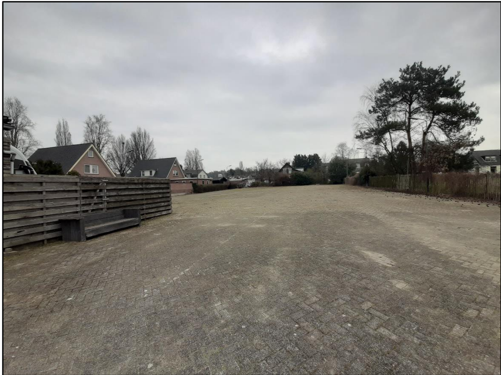
Figuur 5 Verharding ten noordoosten van het bedrijfspand.
