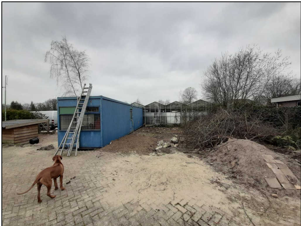
Figuur 4 De noordoostzijde van het bedrijfspand met de container.
